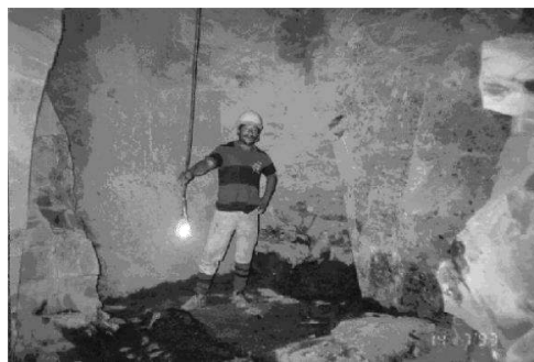
Figura 7.6 - Tubulão a ar comprimido revestido com camisa metálica
