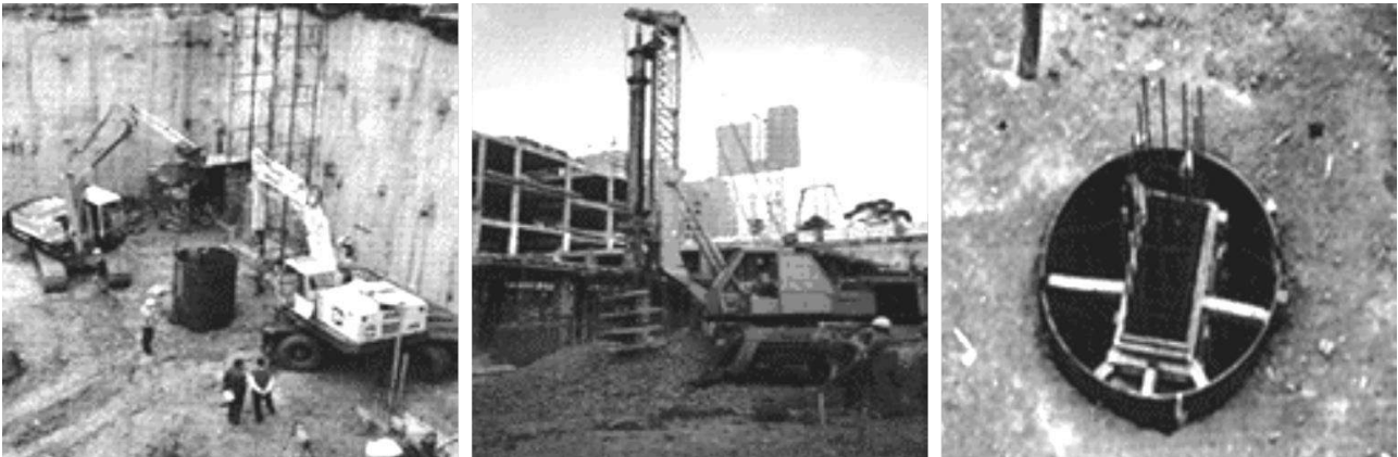
Figura 7.2 - Perfuração e concretagem dos tubulões, pilares moldados "In-Loce" com camisas metálicas-recuperáveis (Shopping Curitiba).
