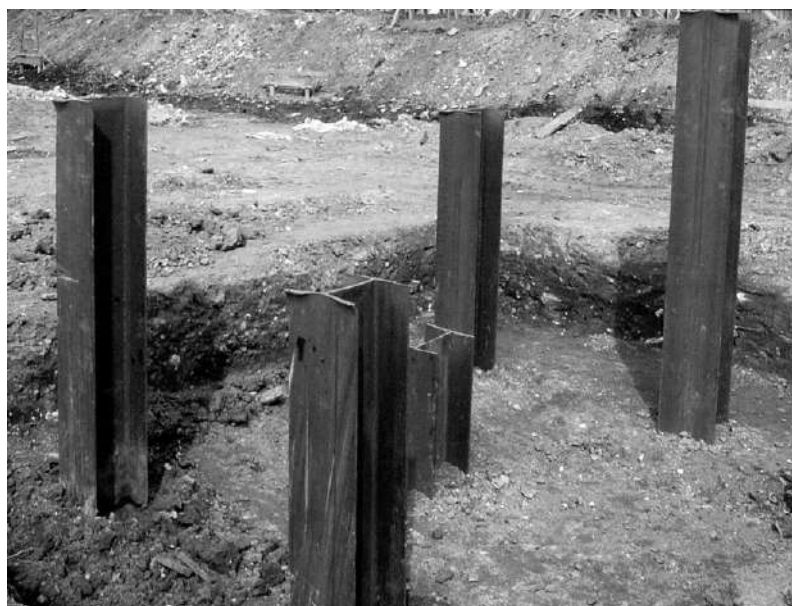
Figura 8.24 – Estaca em aço perfil I (GERDAU AÇOMINAS)
