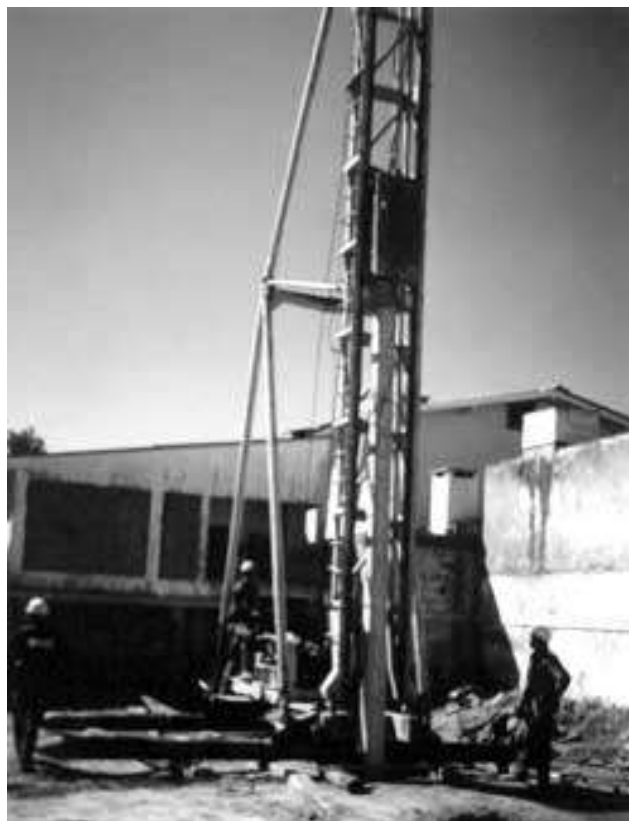
Figura 8.31 - Bate estaca cravando um estaca pré moldada
