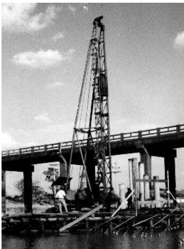
Figura 8.30 - Bate estaca tipo queda livre
