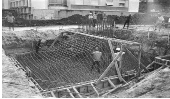
Construção de uma sapata de 7x 9m, executada para fundação de um edifício.
