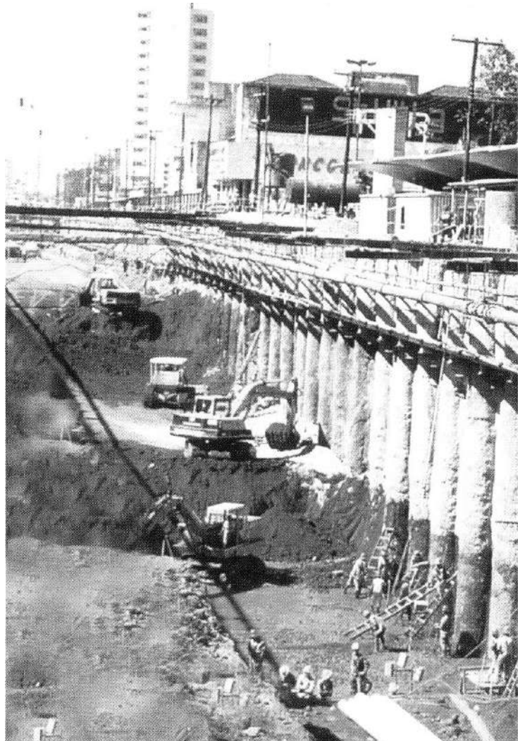
Figura 8.14- Formação do "cake" no processo de estaqueamento com lama bentonita (ANSON S.A.)
