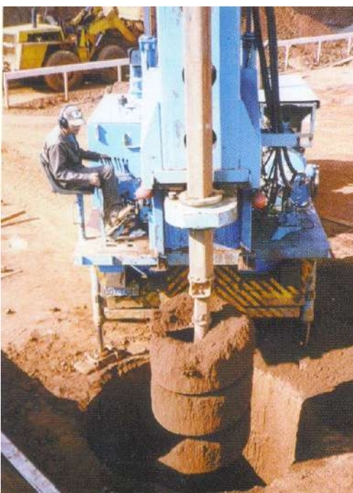
Figura 7.1 - Fustes de tubulões escavados a céu aberto com \varnothing 60cm a \varnothing 120 cm (BASE Fundações e Infra-Estruturas Ltda.)
