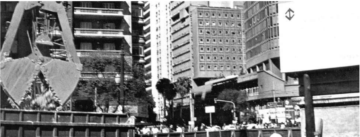
Figura 8.17 – Perfuratriz de estacas barrete - e de paredes diafragma (Metrô República. ANSON Engenharia de Fundações e Recuperações S.A).
