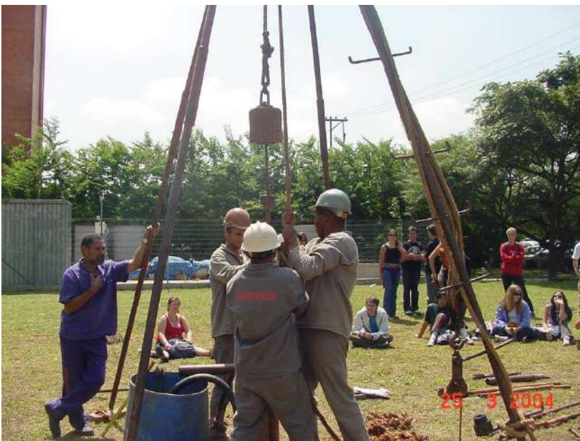
Figura 2.4a – Execução do ensaio de SPT
