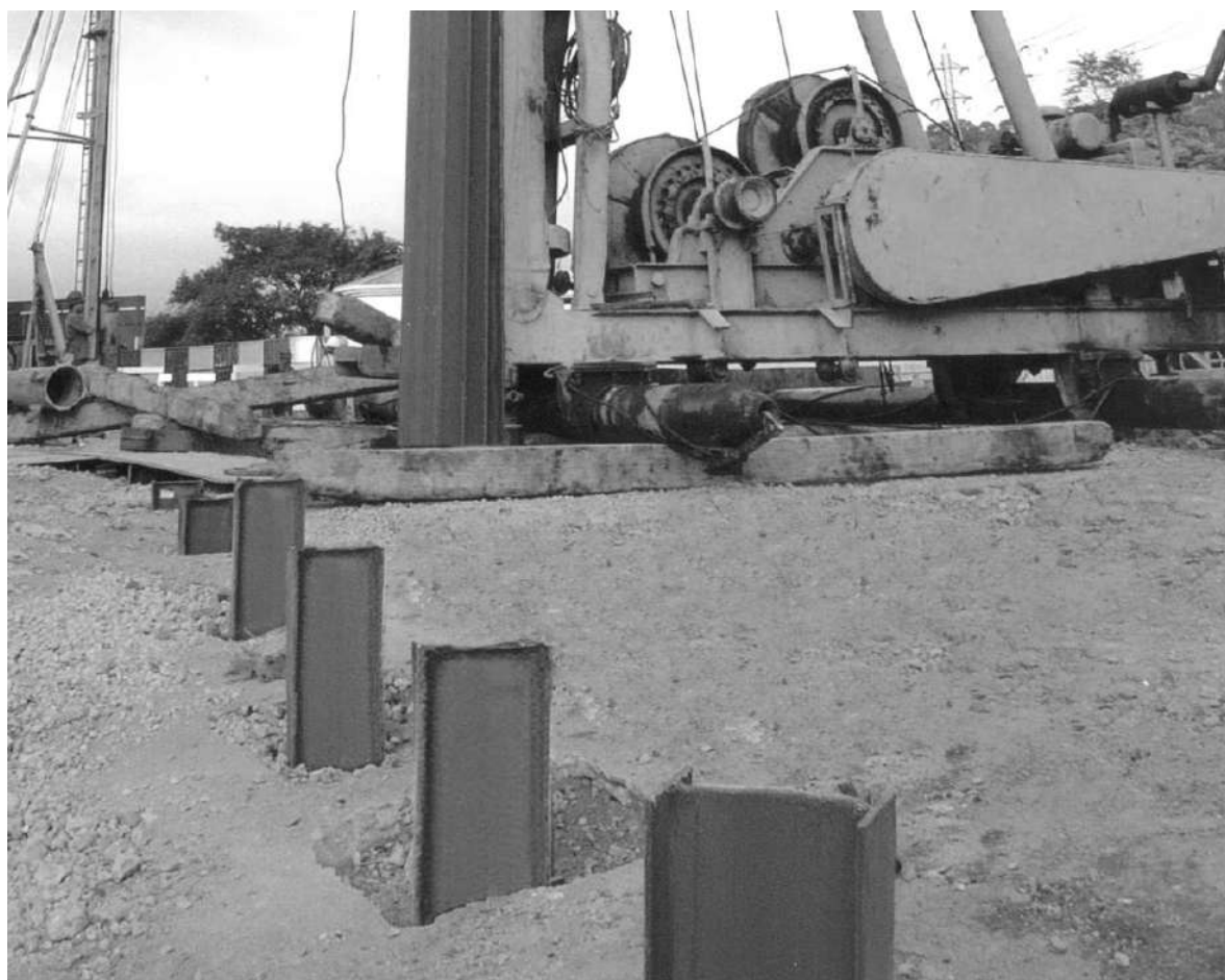
Figura 8.25 – Estaca em aço perfil I e bate estaca.(GERDAU AÇOMINAS)
